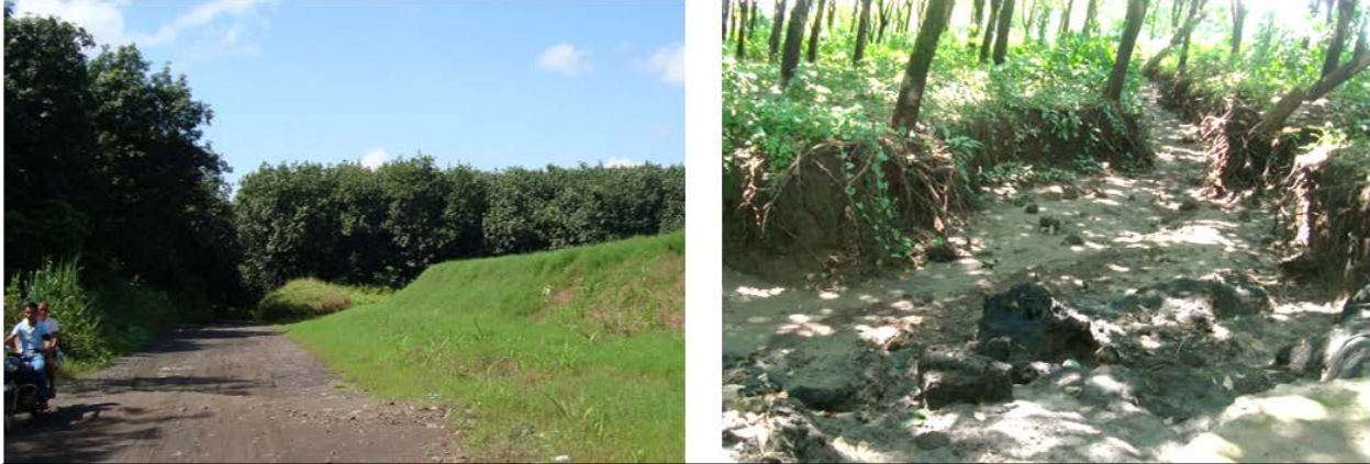
Fotografía 10.11 Sitio Tzululá, corte de calle y canal de drenaje.
