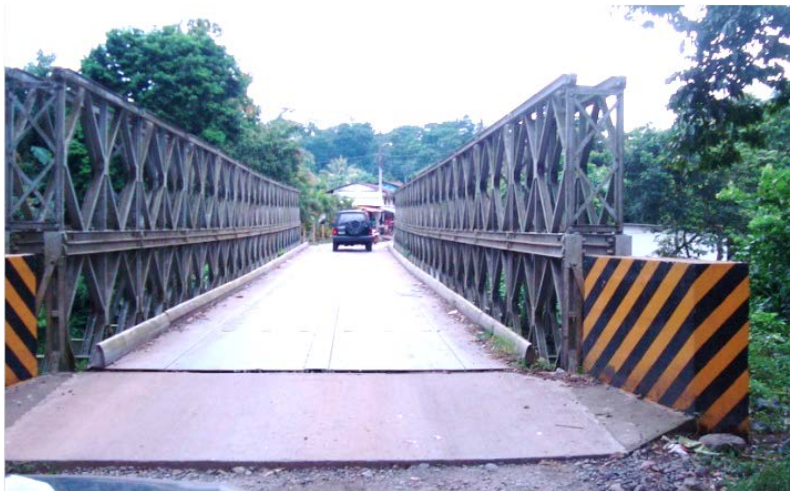
Fotografía 10.13 Puente Bailey sobre río Nimá, Santo Domingo Suchitepéquez.
