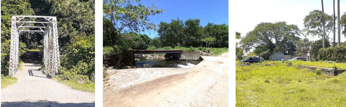
Fotografía 10.12 Puente sobre el río Ixtacapa, río Seco y Estación de FEGUA en Finca Las Ánimas-Melimar.
